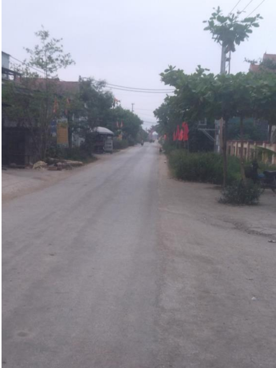
Đường 559 đoạn qua xã
