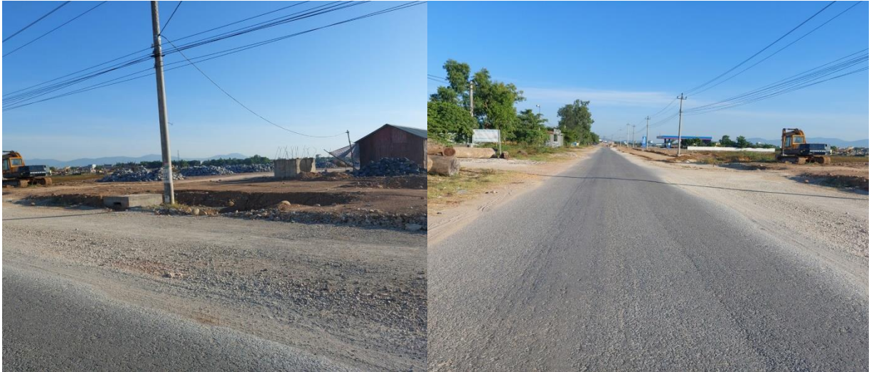
Hình 1: Vị trí dự kiến xây dựng dự án Hình 2: Trục đường chính giáp phía Nam khu vực dự án
